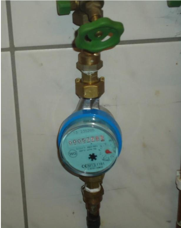
Zwischenzähler mit fachgerechter Verplombung und Einbausituation:
