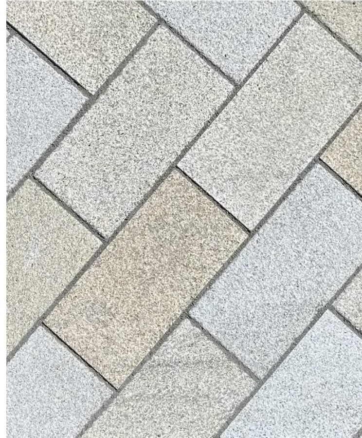
Gehweg Rheinallee Europäischer Granit, Oberfläche gesägt und gestraht Farbe gelb-grau-beige Formate 15/20/25 x 40cm Verlegung im Reihenverband
