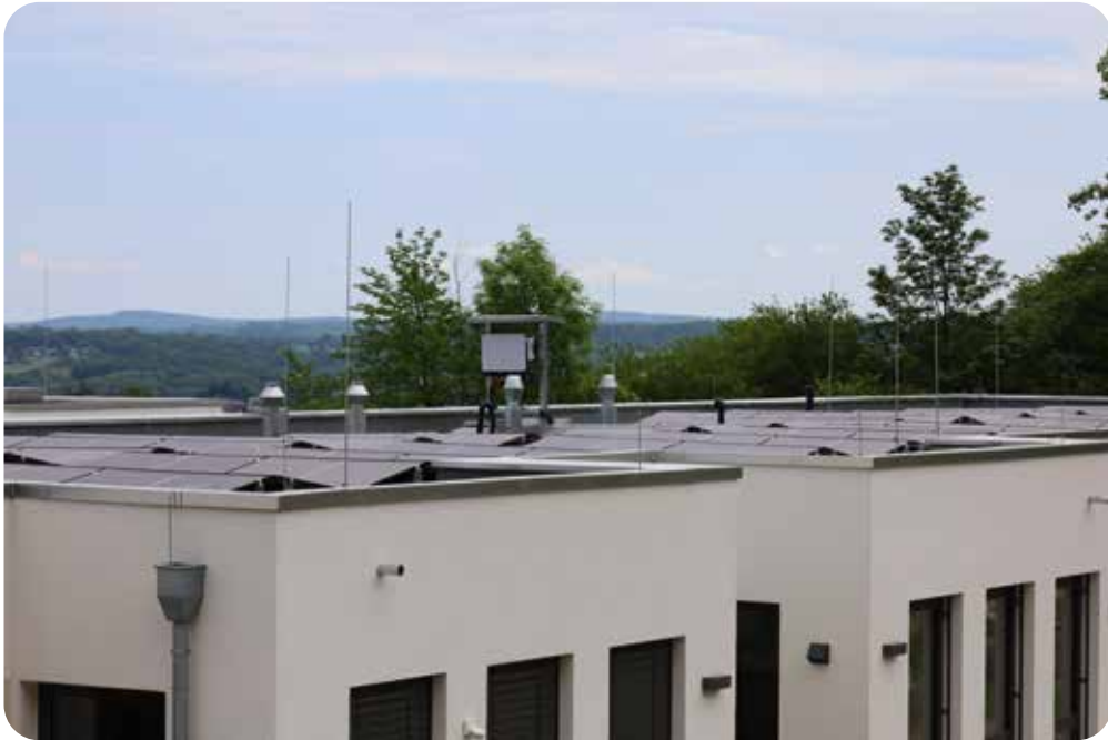
Neue Photovoltaikanlage auf den Dächern der Kindertagesstätte „Am Limperichsberg“ in Thomasberg
