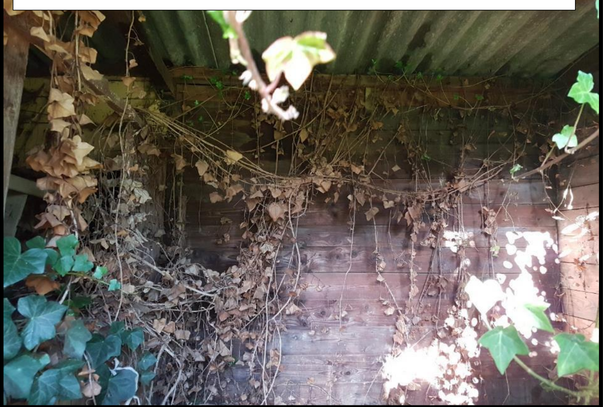
Innenansicht vom Schuppen, keine Deckenverkleidung oder geeignete Spalten zwischen Holzlamellen vorhanden. Keine Eignung als Fledermausquartiere.
