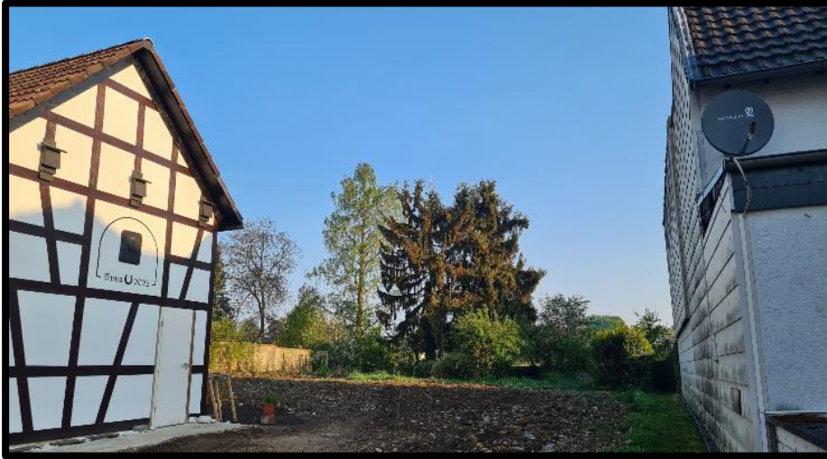
Südliches Plangebiet im April 2022 nach Abriss der Gebäude und Schuppen im Winter 2021.
