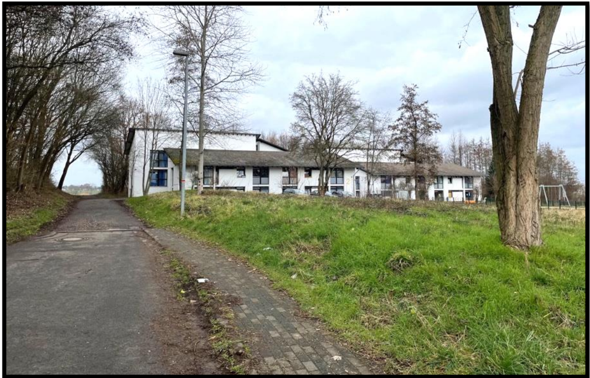
Abb. 6: Ansicht auf die Bestandsgebäude und die Straße „Am Sportplatz“ – Aufnahme-standpunkt Ost.
