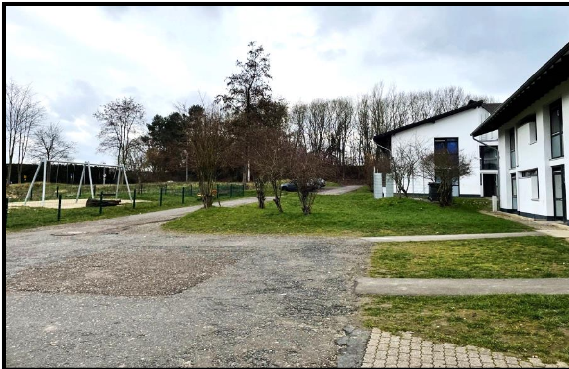
Abb. 7: Blick auf die Bestandgebäude mit versiegelten Wegen und Plätzen.
