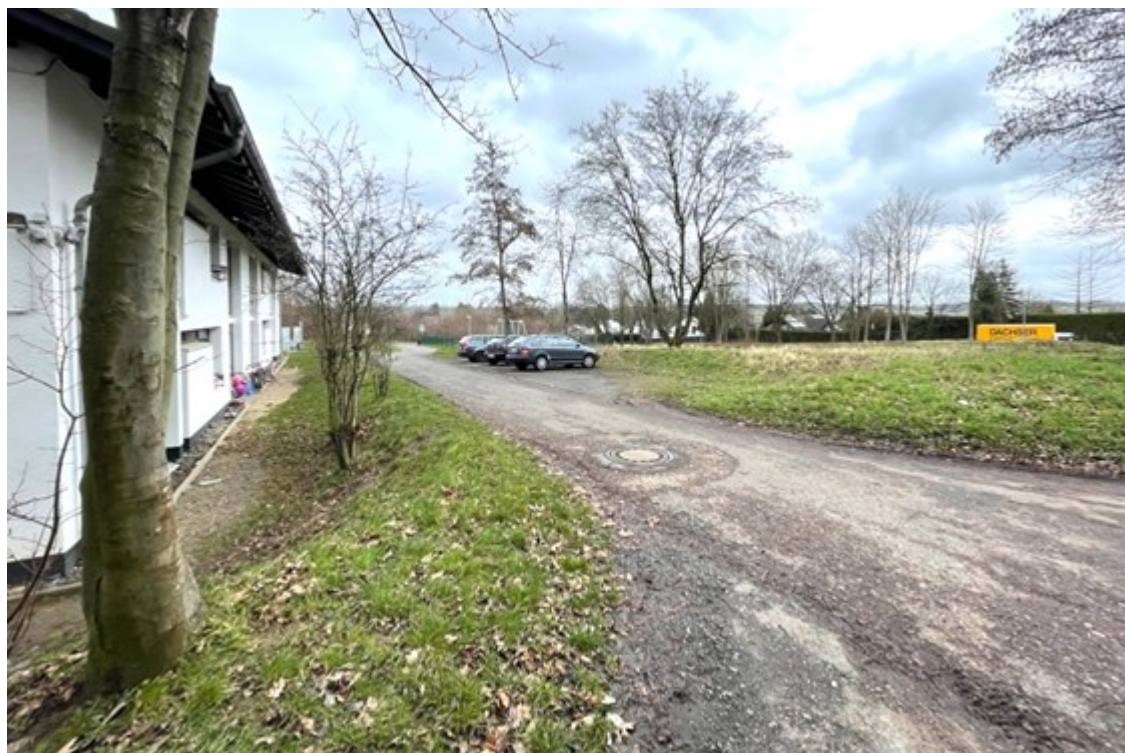
Abbildung 6: Bereich Wohngebäudebestand mit innerer Erschließung und Gehölzgruppen (Quelle: N. Claßen )
