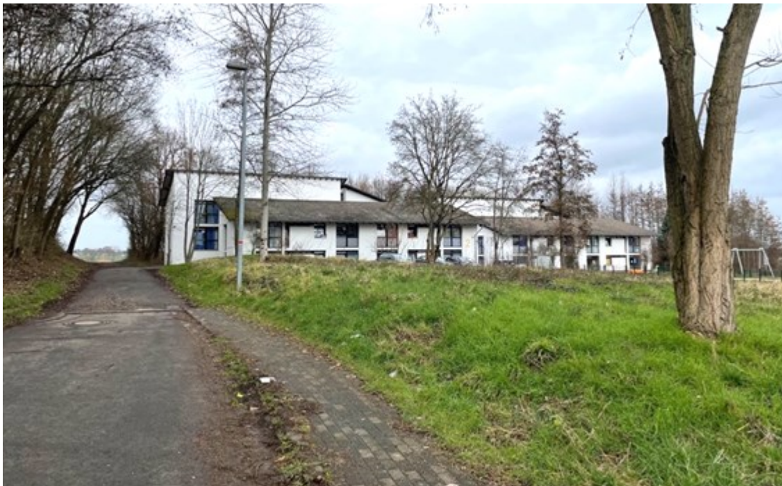
Abbildung 5: Südgrenze – Blick von Westen nach Osten – Baulicher Bestand (Quelle: N. Claßen )
