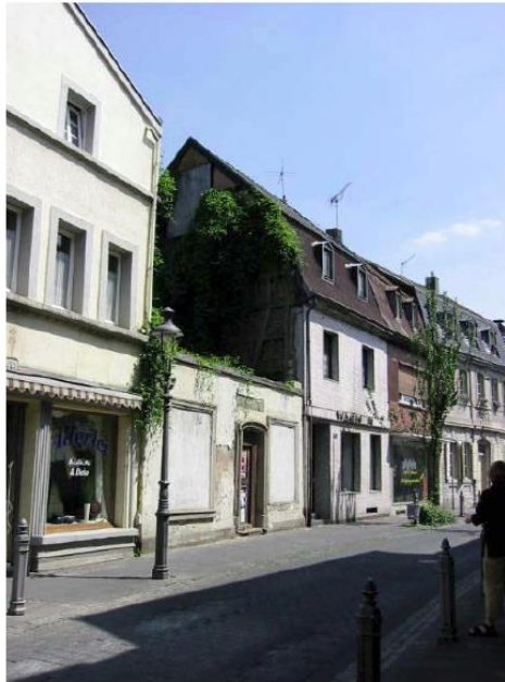
Abbildung 19: Ansicht der zwischenerworbenen Grundstücke in der südlichen Hauptstraße vor dem Gebäudeabbruch. Foto: Stadt Königswinter.
