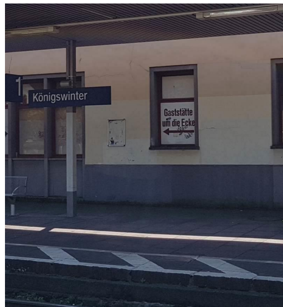
Abbildung 24: Dieses Hinweisschild für eine längst geschlossene Gaststätte im Empfangsgebäude des Bahnhofs soll in Zukunft kein leeres Versprechen mehr sein. Foto: Stadt Königswinter.
