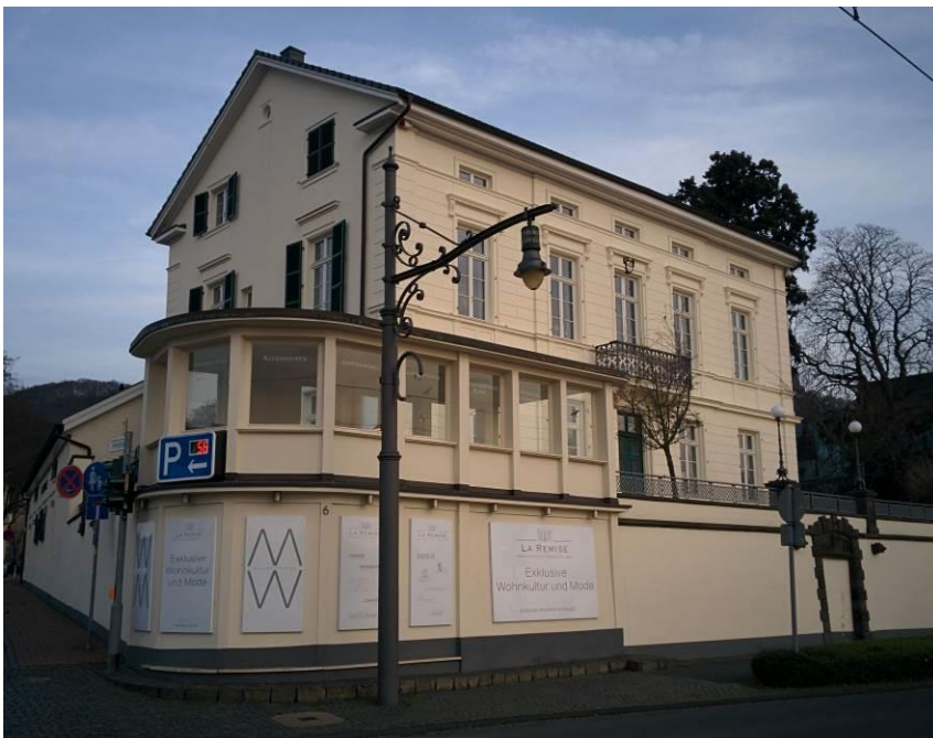
Abbildung 32: Der Immenhof nach der Sanierung.
