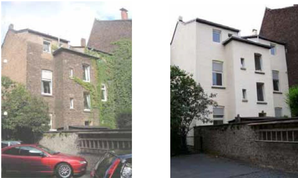
Abbildung 26: Vor und nach der Fassadensanierung. Foto: Stadt Königswinter.
