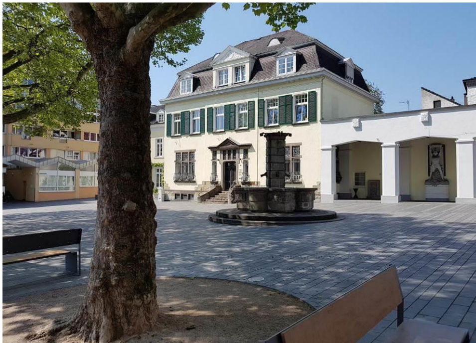
Abbildung 8: Im Zuge der Umgestaltung wurde der Marktplatz zu einem Stadtraum mit hoher Aufenthaltsqualität. Foto: Stadt Königswinter.
