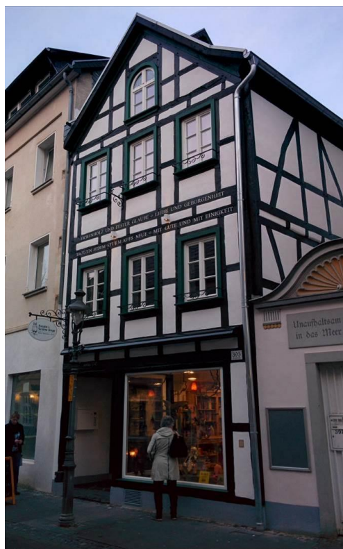
Abbildung 21: Hauptstraße 395 nach der Sanierung.
