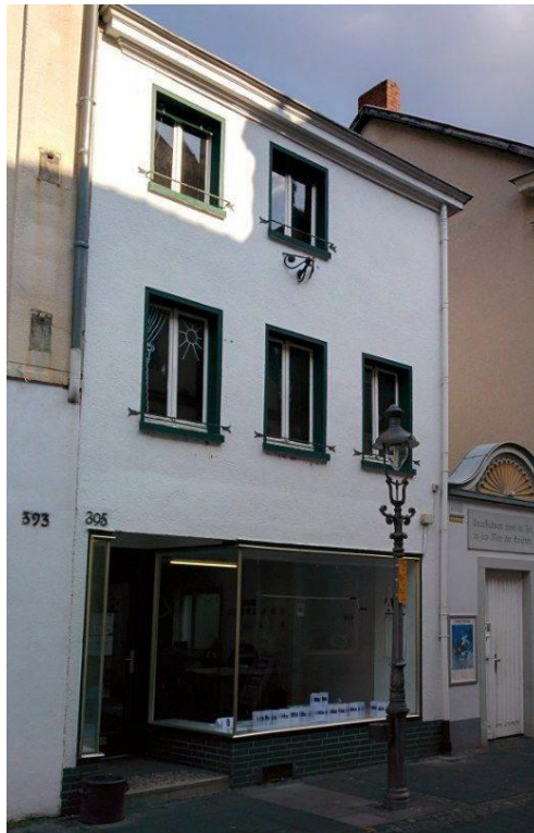
Abbildung 20: Das Gebäude Hauptstraße 395 vor der Sanierung. Foto: Stadt Königswinter.
