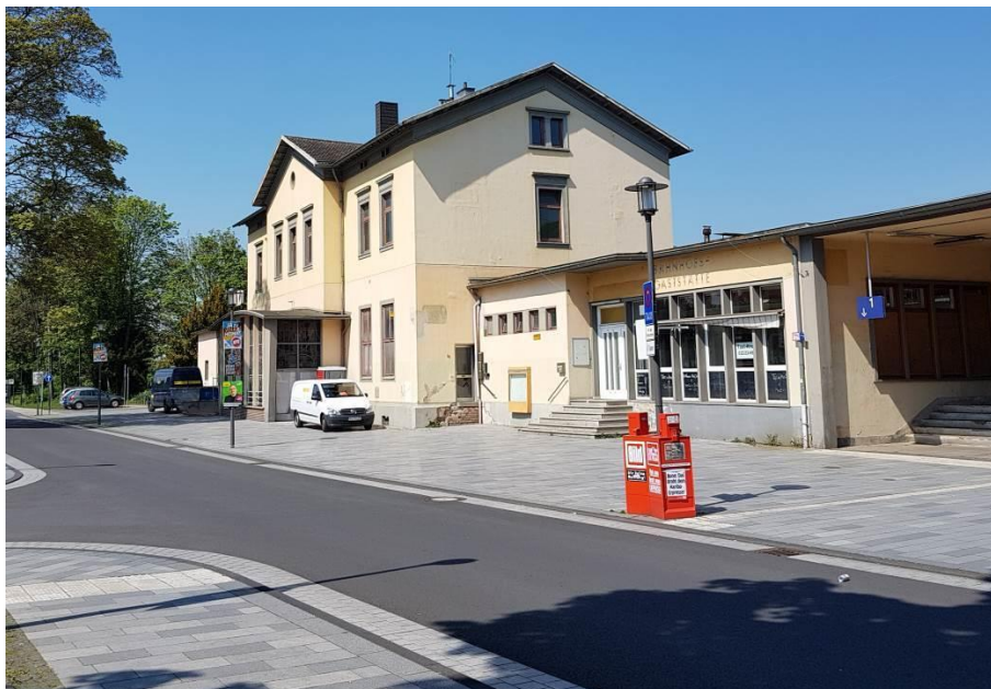
Abbildung 5: Die neugestaltete Bahnhofsallee und der neue Bahnhofsvorplatz mit dem derzeit noch leerstehenden Empfangsgebäude des Bahnhofs. Auf dem Bild ist zu erkennen, dass im Gebäude bereits erste vorbereitende Arbeiten des neuen Eigentümers stattfinden. Foto: Stadt Königswinter.
